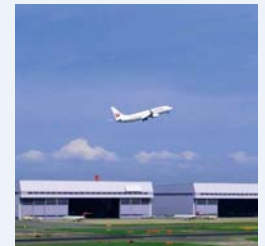
その他(インフラ施設) IIF羽田空港メンテナンスセンター 産業ファンド投資法人 所在地: 東京都大田区
