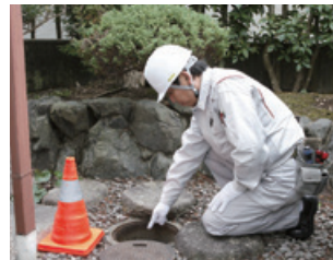
外部排水の診断
