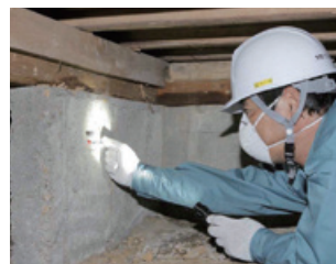
床下基礎の診断
